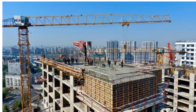
Рисунок 4 - Технологический процесс возведения монолитного каркаса здания
