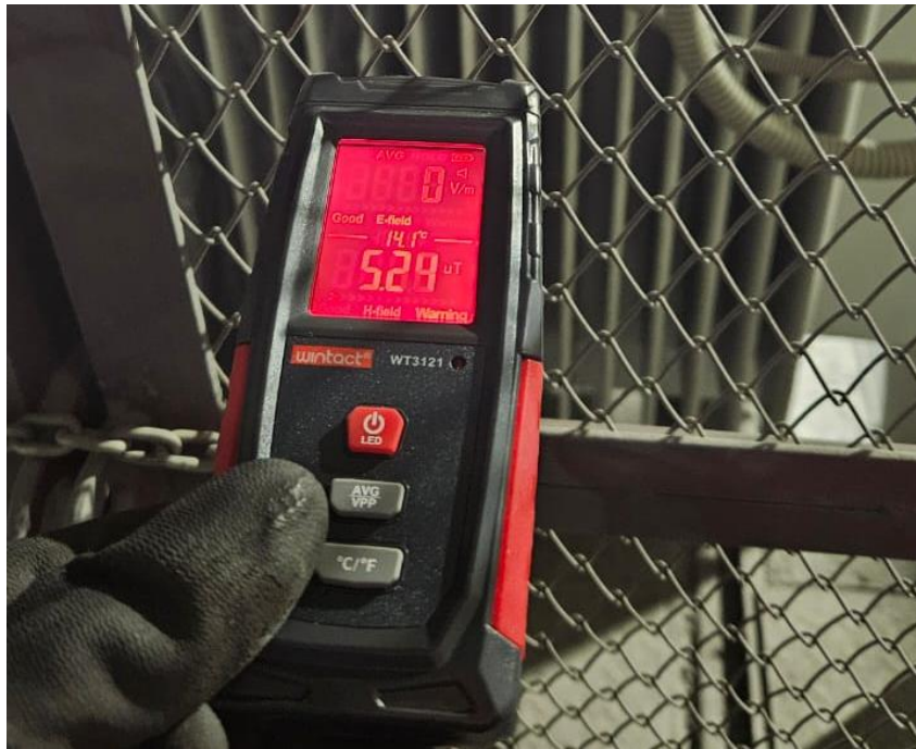
Рисунок 3 – Измерение полей в помещении трансформаторов
